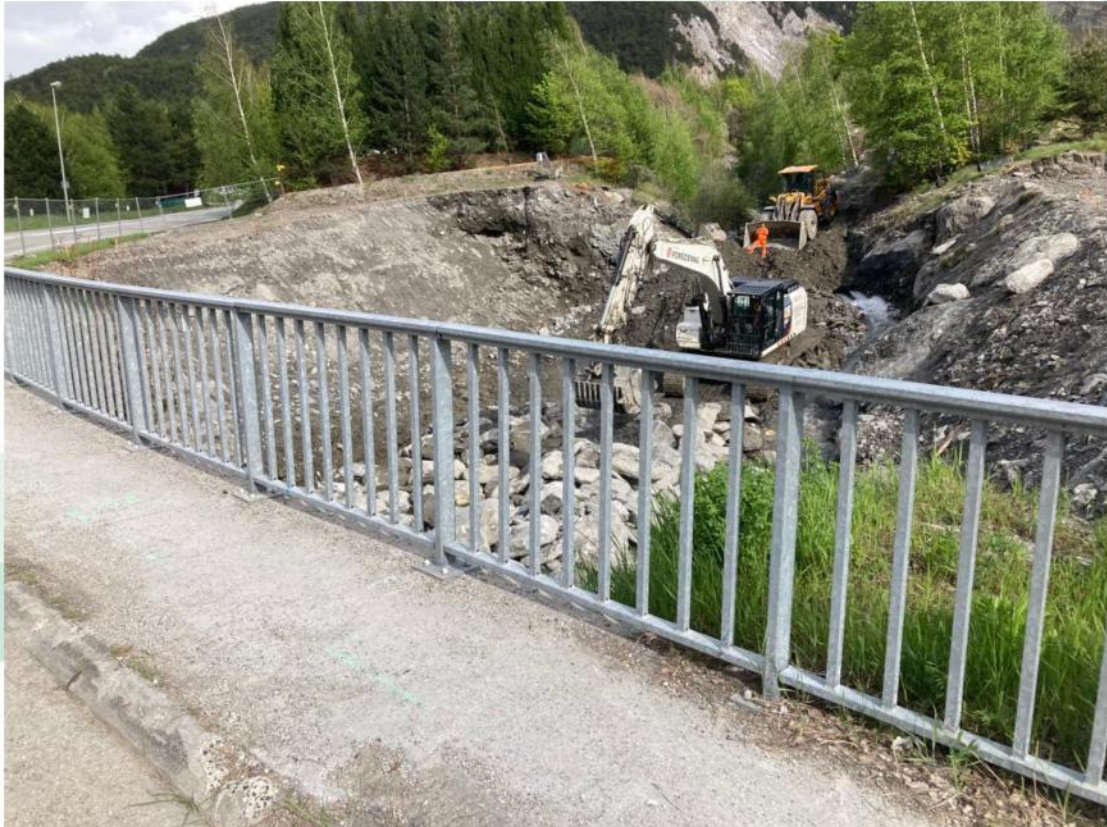
Pont Saint-Antoine / travaux d'enrochement du radier
