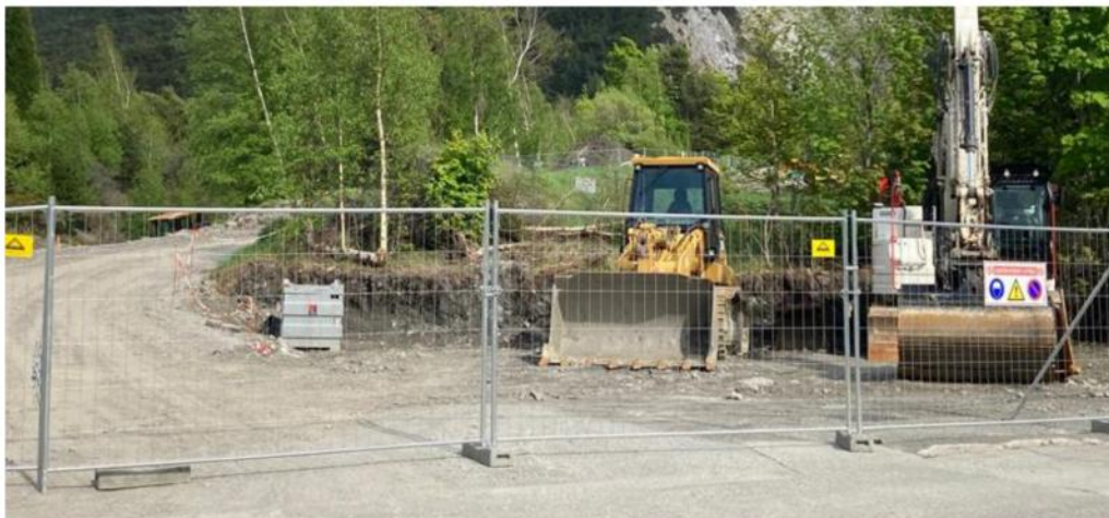
Entrée du chantier et zone étanche de stockage du matériel
